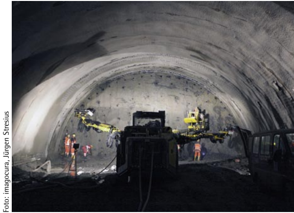
Bild 3: Bohren der Sprenglöcher beim Kalottenvortrieb
