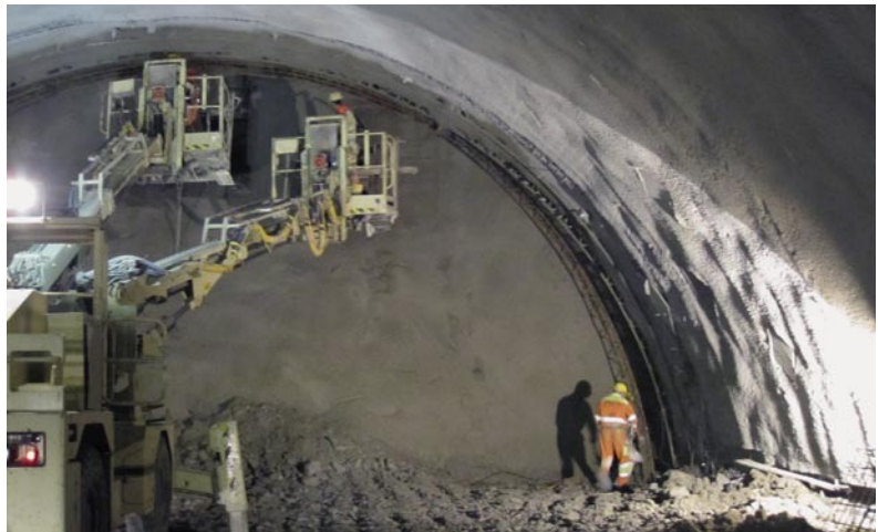
Bild 5: Stellen der TunnelbÖgen im Bereich der Ortsbrust
