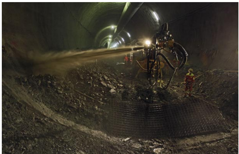
Bild 6: Einbau des Spritzbetons beim Sohlvortrieb
