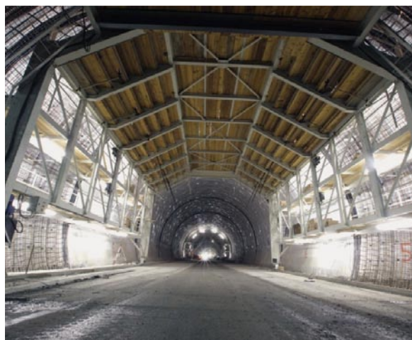
Bild 17: Bewehrung im Bereich der Innenschale des Gewölbes
