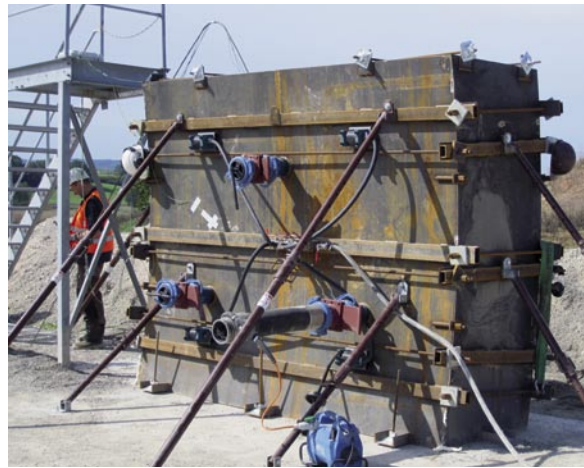
Bild 9: Probebetonage der Innenschale
