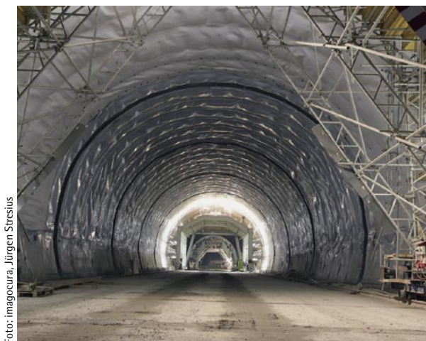
Bild 16: Abdichtung im Bereich des Gewölbes
