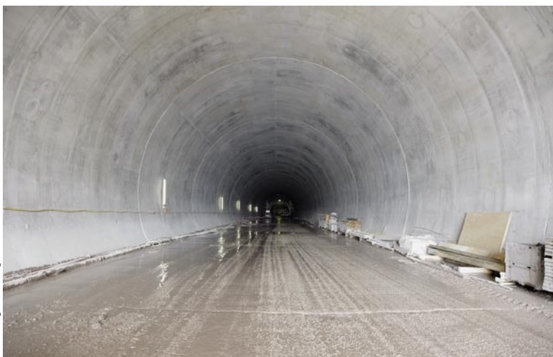
Bild 19: Fertiggestellte Innenschale
